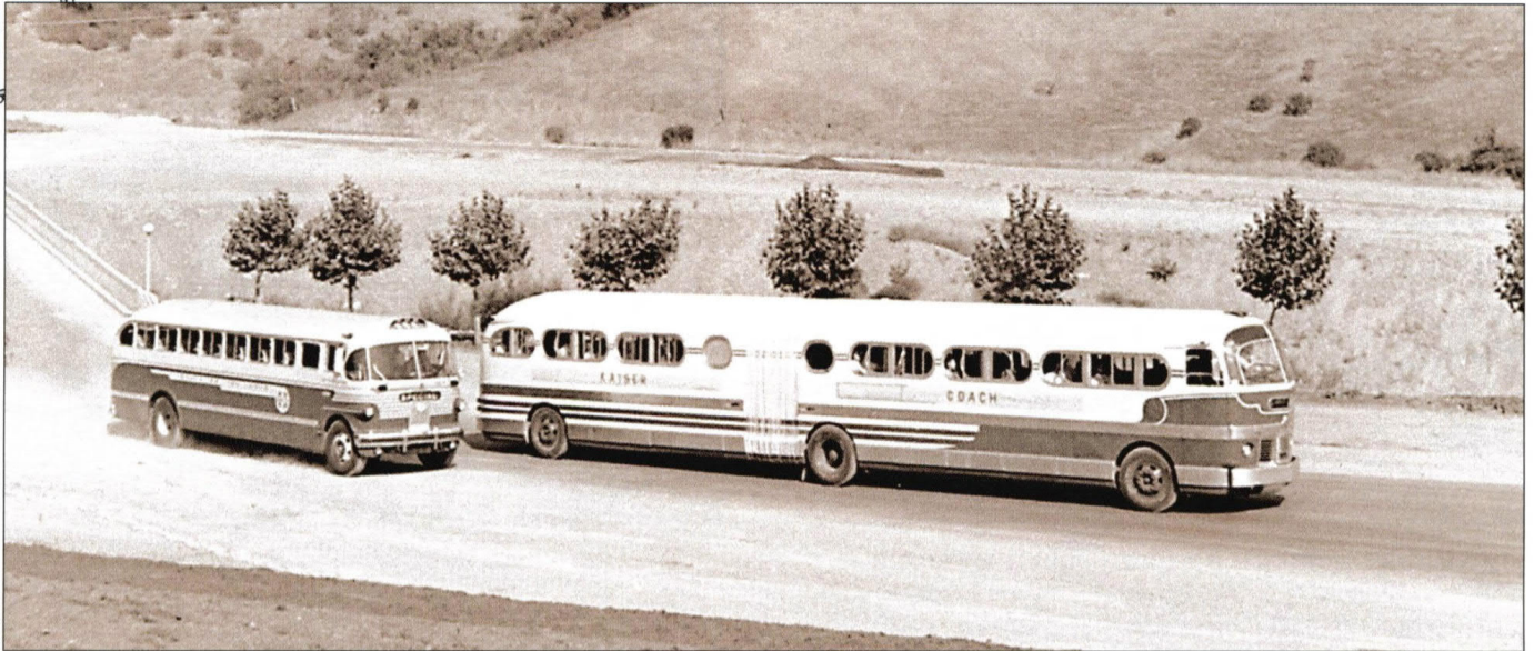
Сочлененный автобус фирмы «Кайзер» в сравнении с обычным междугородным автобусом
